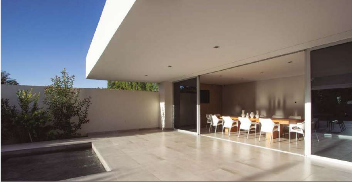
El sello distintivo de la obra es su voladizo de casi cuatro metros sólo apoyado en sus extremos.
